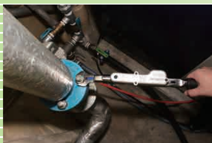
エア配管フランジ部締め付けでの使用例 (MPQL/MQSP型では頭部が配管にあたる)
